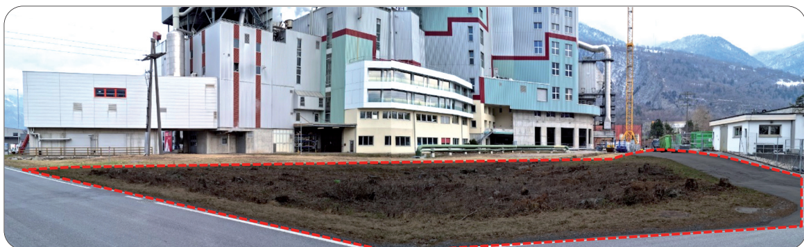
Abbildung 3: Panoramabild des Bereichs für den Zentralenstandort (Baurechtsfläche rot eingefärbt).
